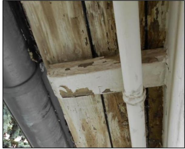
Abbildung 14: Spaltenpotential durch Fugen zwischen den Holzlamellen in Dachüberstand
