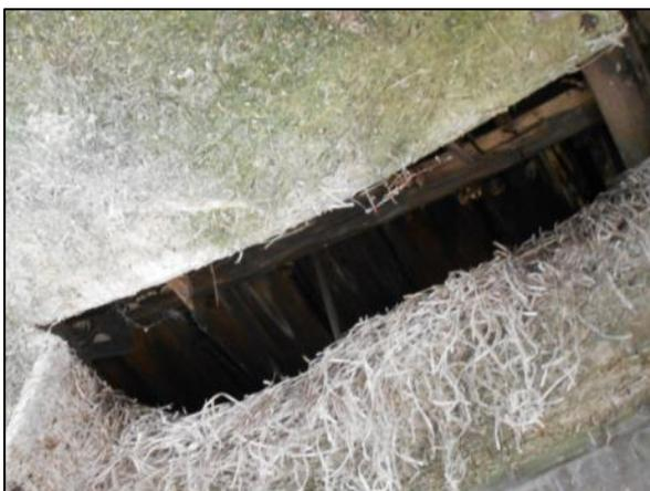
Abbildung 16: Spaltenpotential im Dachbereich von Gebäude durch defektes Dämmmaterial
