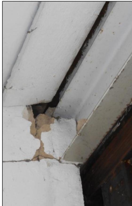
Abbildung 12: Spaltenpotentiale an Wänden in Schuppen durch herausgebrochenes oder verwittertes Material
