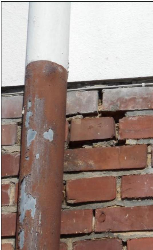
Abbildung 11: Spaltenpotentiale im Gemäuer des Verwaltungsgebäudes an der Süd-Ostfassade durch herausgebrochenes oder verwittertes Material
