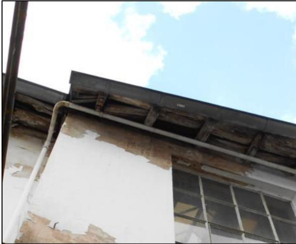
Abbildung 13: Spaltenpotential durch verwitterten Dachüberstand an altem Produktionsgebäude
