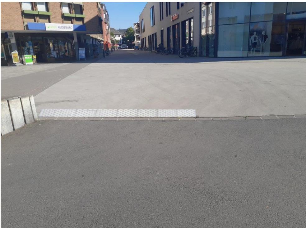
Abbildung 2: Markierung steiler Abgang
