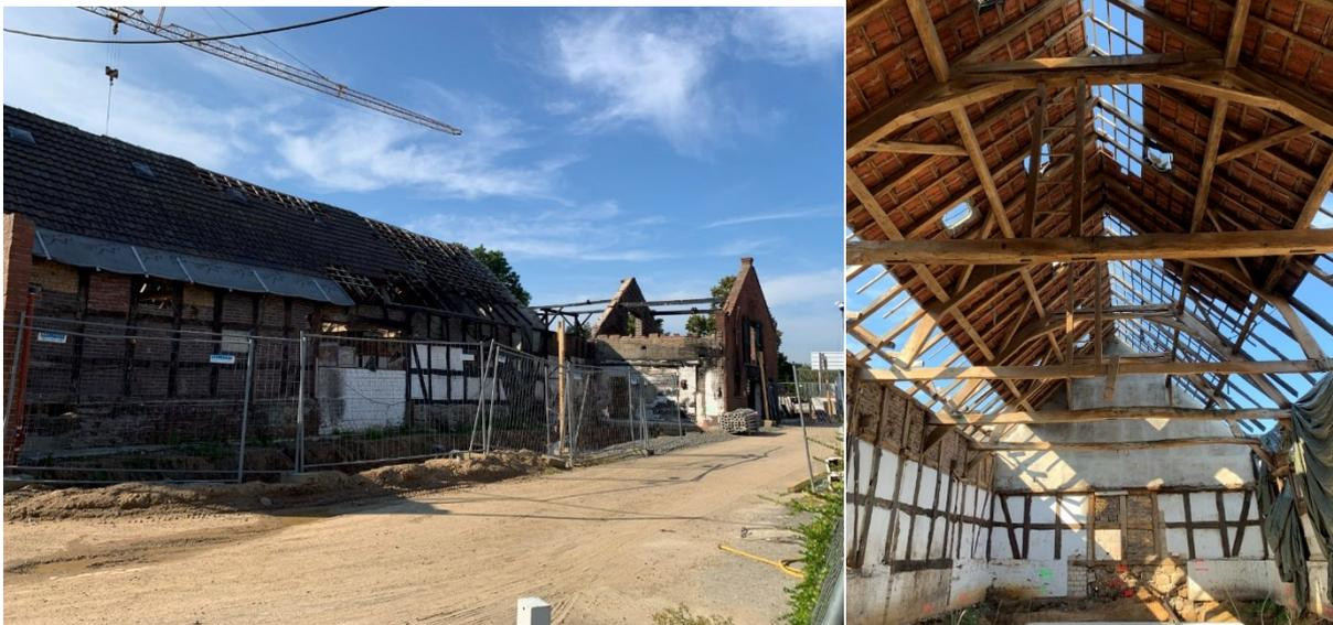
Zustand der geschädigten Gebäude am 14.09.2021, links die Fachwerkscheune, rechts das Gebäude aus dem 19. Jh., in dem sich der Brandherd befand. Und Blick in das Innere der Fachwerkscheune.
